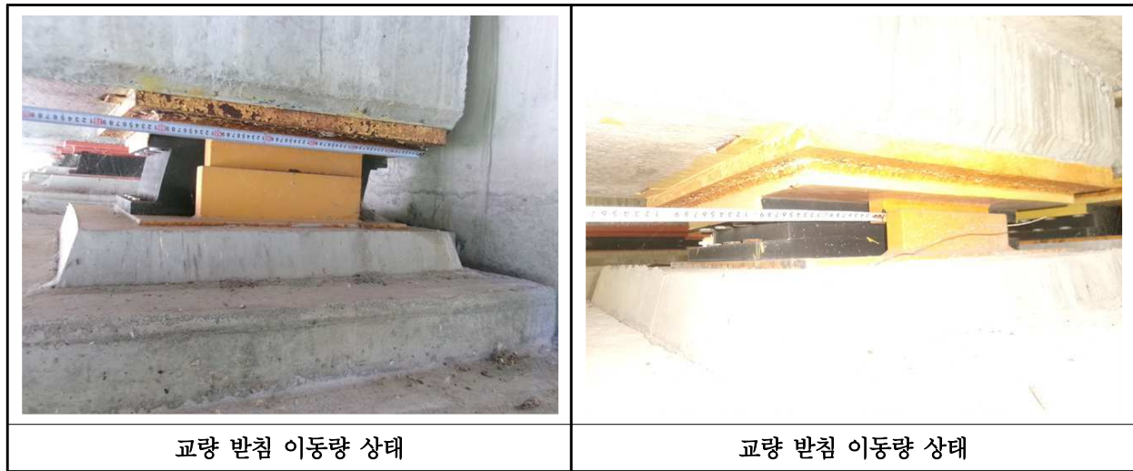
【사진 29.3.40】 교량받침 이동량 상태
