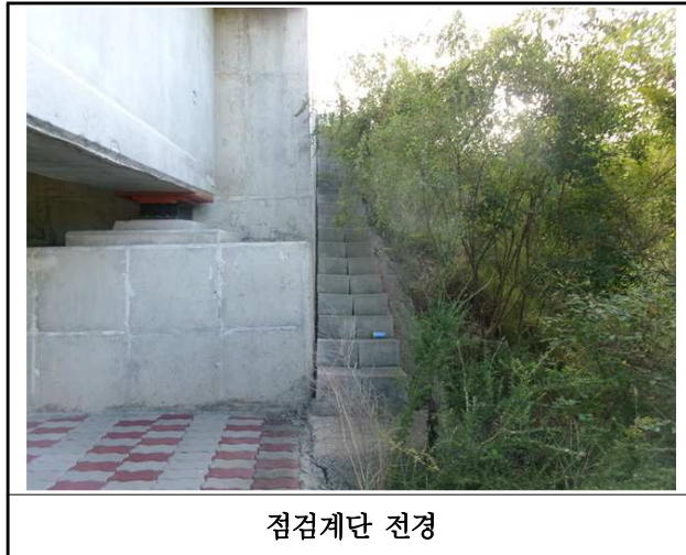
【사진 29.3.50】 교량 점검시설 전경
