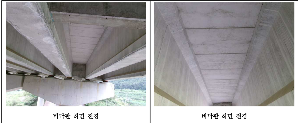
【사진 29.3.27】 바닥판하면 전경
