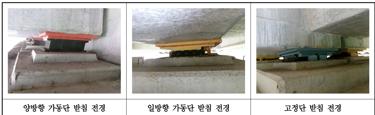
【사진 29.3.37】 교량받침 전경
