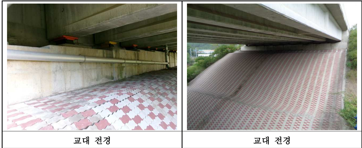
【사진 29.3.33】 교대 전경
