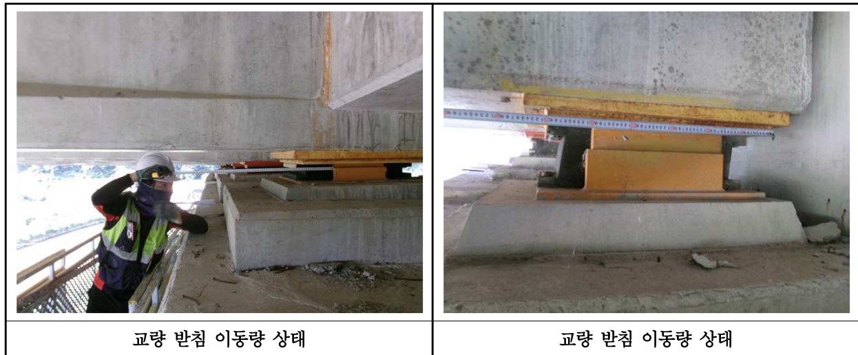
【사진 29.3.15】 교량받침 이동량 상태
