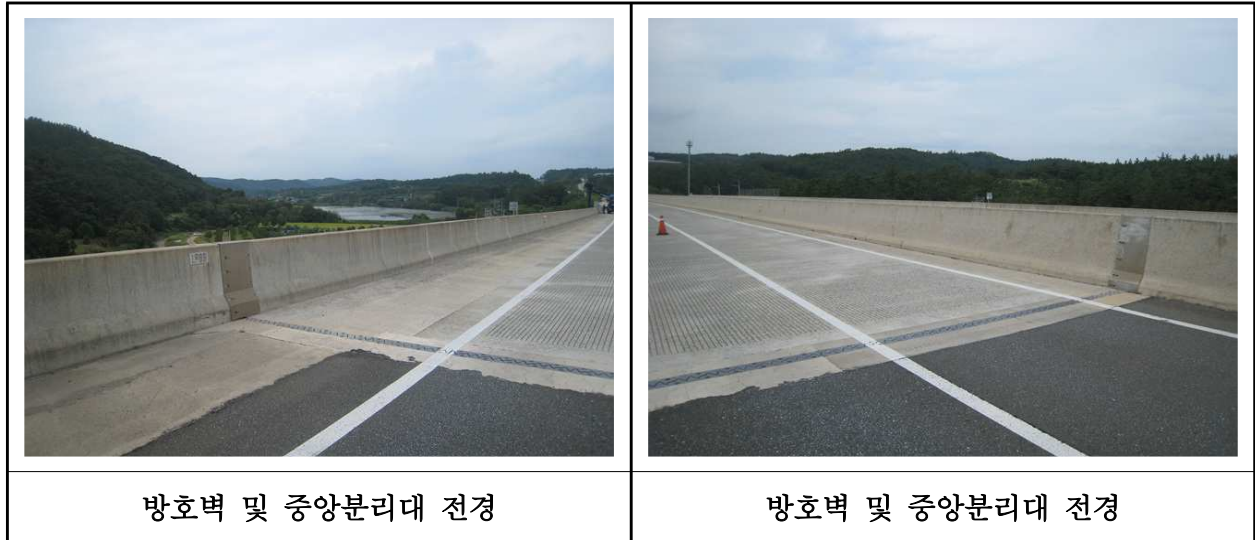
【사진 29.3.48】 방호벽 및 중앙분리대 전경
