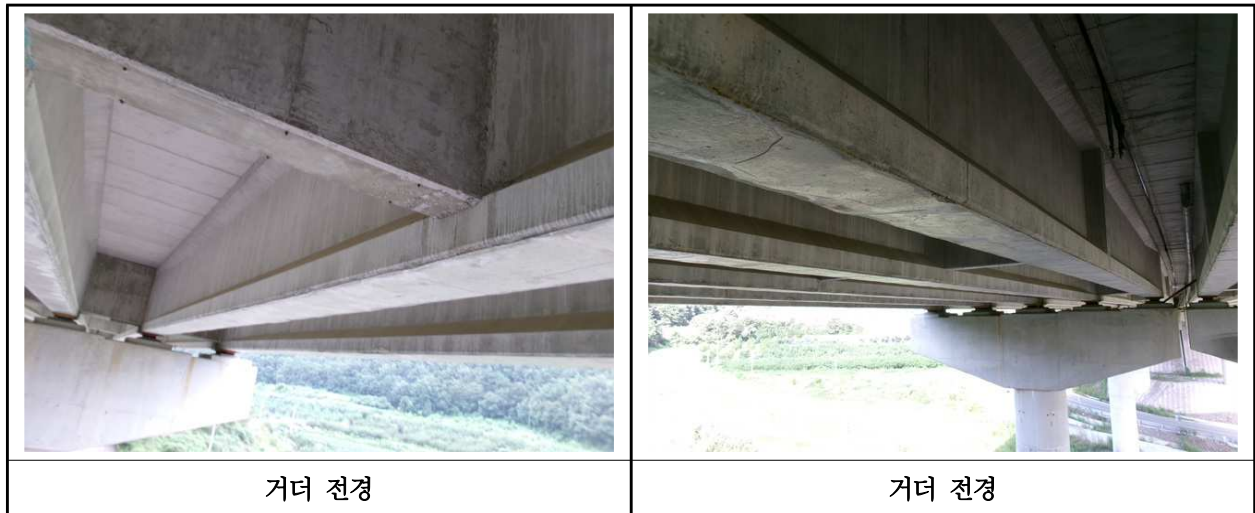
【사진 29.3.29】 거더 전경
