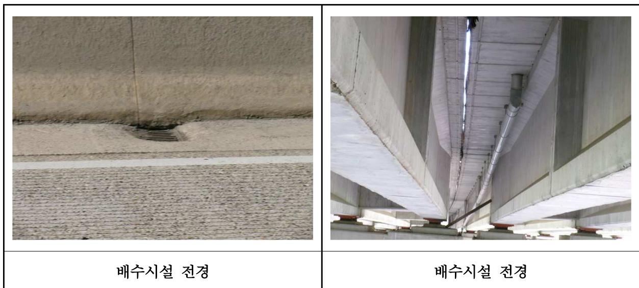
【사진 29.3.21】 배수시설 전경
