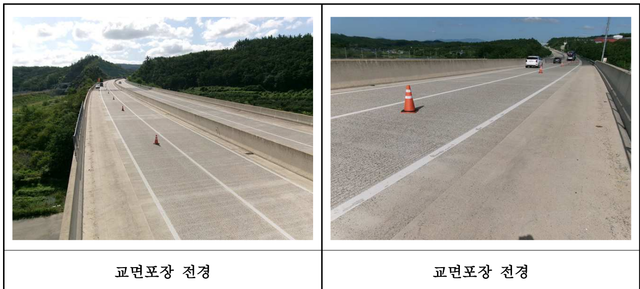
【사진 29.3.19】 교면포장 전경
