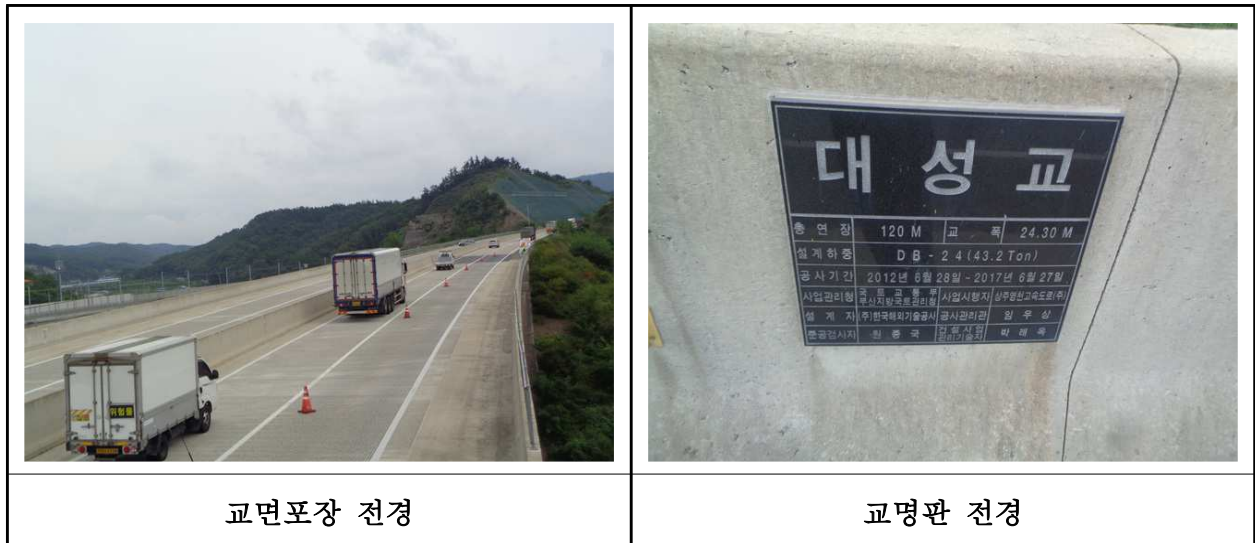
【사진 29.3.44】 교면포장 전경
