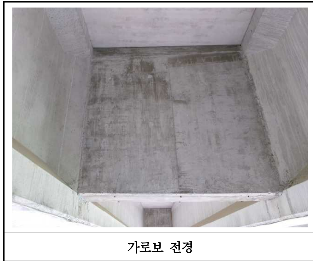
【사진 29.3.31】 가로보 전경
