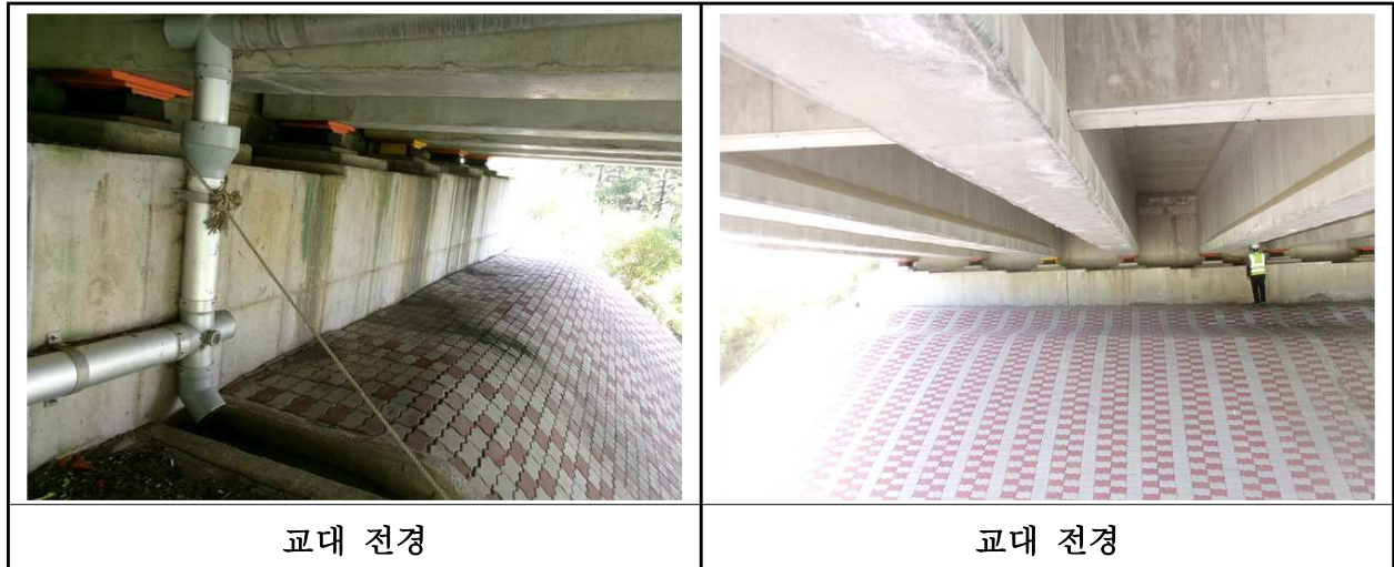
【사진 29.3.8】 교대 전경
