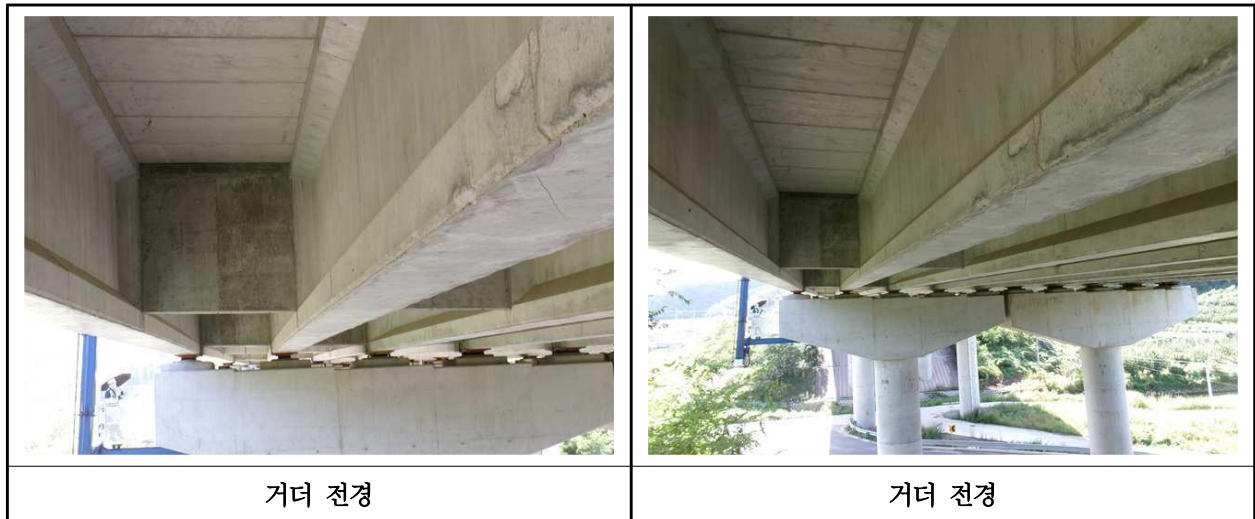
【사진 29.3.4】 거더 전경
