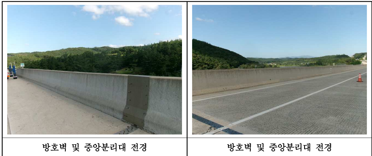
【사진 29.3.23】 방호벽 및 중앙분리대 전경
