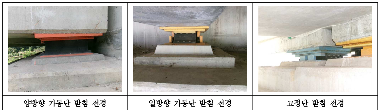
【사진 29.3.12】 교량받침 전경
